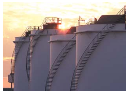
原油貯蔵タンク
