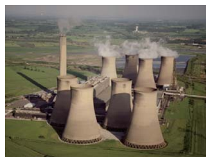
電力プラント・ボイラー
